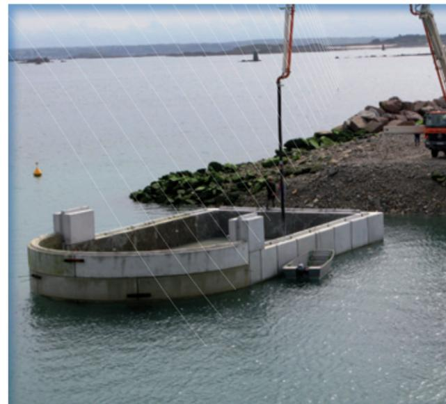
digue constituée de 125 000 m<sup>3</sup> de remblais et de 310 000 tonnes d'enrochements, 211 000 m<sup>3</sup> de terrassement, 31 800 m<sup>3</sup> de béton, 250 ml de pontons brise clapots, 392 tonnes de pieux et 42 500 tonnes d'enrochements pour divers aménagements de protection.
