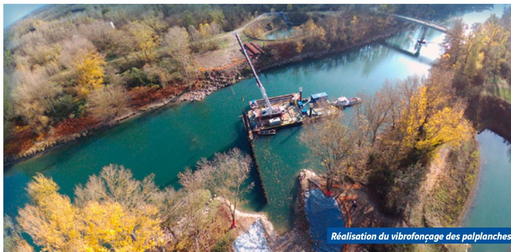
Réalisation du vibrofonçage des palplanches
