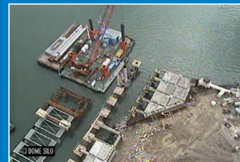
C'est le groupement d'entreprises SEMEN (mandataire) GTMF (Eiffage) et EMCC (VINCI) qui a obtenu le marché. La principale difficulté de cet ouvrage a été la mise en œuvre des pieux métalliques qui ont nécessité au préalable un pré-minage au droit de chaque pieu afin de permettre un ancrage suffisant dans le rocher.
