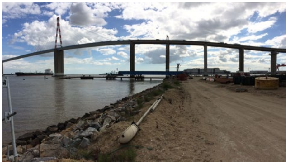
Chantier de l'apportement Ro-Ro 3 à Montoir-de-Bretagne (44) : un bel exemple de l'utilité du Guide sécurité des Travaux Maritimes.
