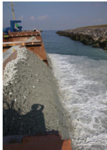
Pour la constitution de digues de protection, des barges à déchargement latéral peuvent être utilisées pour conforter les ouvrages ou mettre en œuvre des enrochements de protections.
