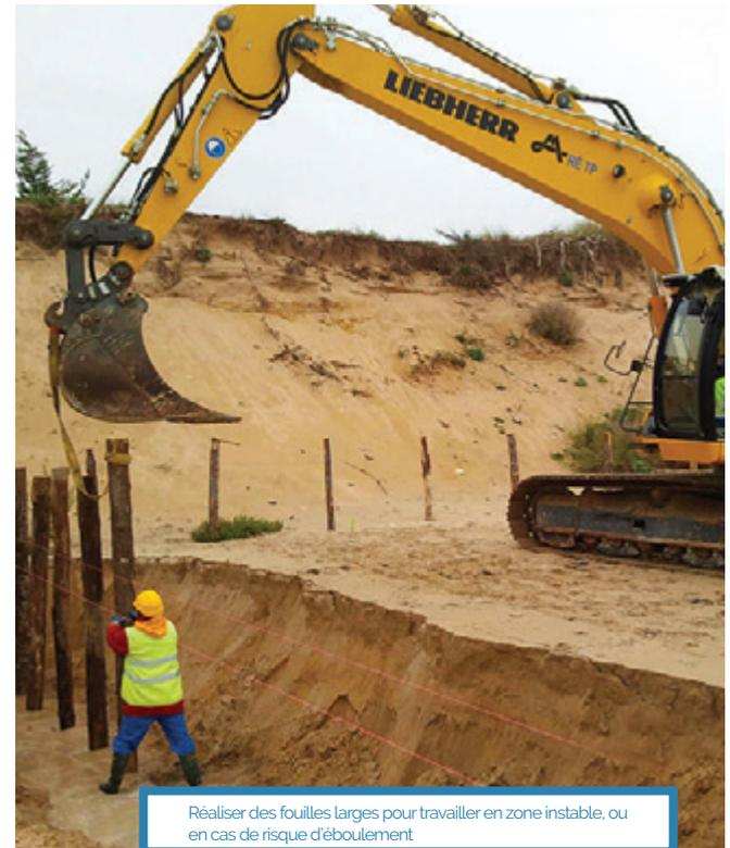
Réaliser des fouilles larges pour travailler en zone instable, ou en cas de risque d'éboulement
