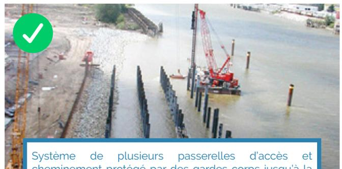
Système de plusieurs passerelles d'accès et cheminement protégé par des gardes corps jusqu'à la zone de travail
