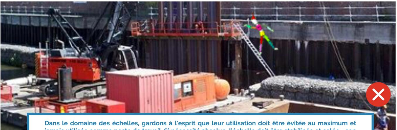
Dans le domaine des échelles, gardons à l'esprit que leur utilisation doit être évitée au maximum et jamais utilisée comme poste de travail. Si nécessité absolue, l'échelle doit être stabilisée et calée - son utilisateur doit être assuré au maximum et surveillé par un tiers.
