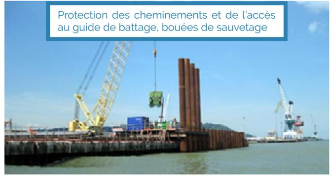
Protection des cheminements et de l'accès au guide de battage, bouées de sauvetage
